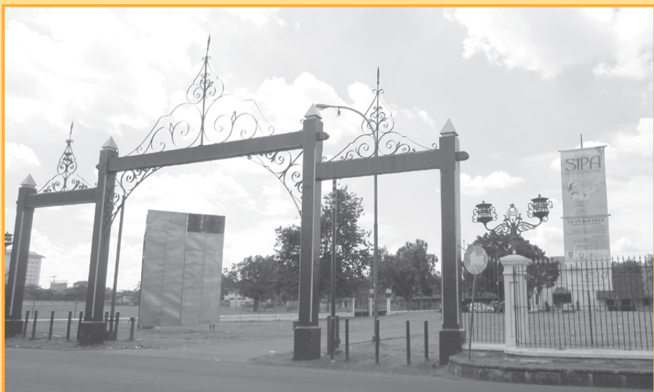
Keraton Mangkunegaran di Keprabon
